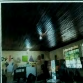
Foto 11: Vista de Modulo de aula, vista interior, retiro de cielo falso de madera, cambio de estructura de madera por estructura de metal a base de tijeras y costaneras.Cubierta de asbesto por lamina troquelada cal 26.
