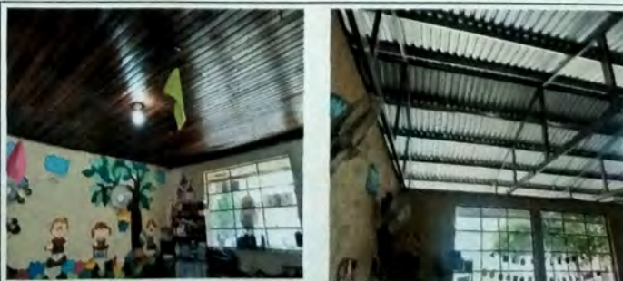
Foto 6: Vista de Modulo de aula, vista interior, retiro de cielo falso de madera en malas condiciones, cambio de estructura de madera por estructura de metal a base de tijeras y costaneras. cubierta de asbesto por lamina troquelada cal 26.
