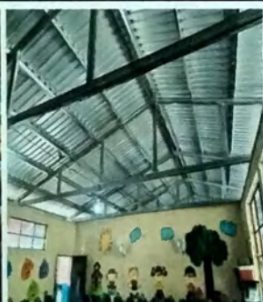
Foto 9: Vista de Modulo de aula, vista interior, retiro de cielo falso de madera en malas condiciones, cambio de estructura de madera por estructura de metal a base de tijeras y costaneras. Cubierta de asbesto por lamina troquelada cal 26.
