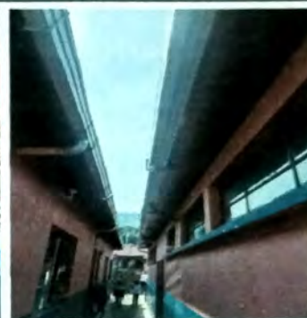
Foto 8: Vista de voladizos con canal galvanizado y bajadas de pvc.
