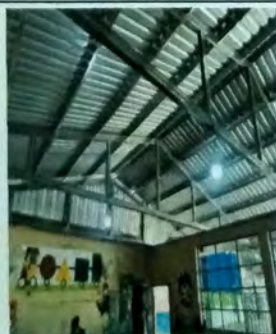
Foto 11: Vista de Modulo de aula, vista interior, retiro de cielo falso de madera, cambio de estructura de madera por estructura de metal a base de tijeras y costaneras.Cubierta de asbesto por lamina troquelada cal 26.
