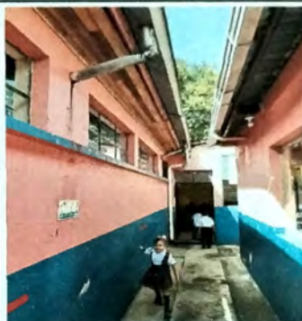
Foto 8: Vista de voladizos con canal galvanizado y bajadas de pvc.
