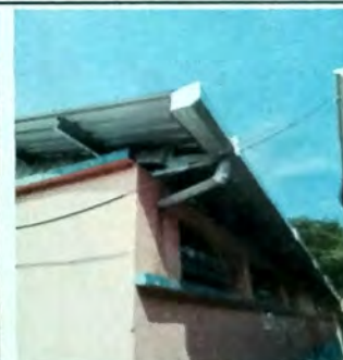
Foto 10: Vista de voladizos con canal galvanizado y bajadas de pvc.se observa la lamina troquelada cal 26.
