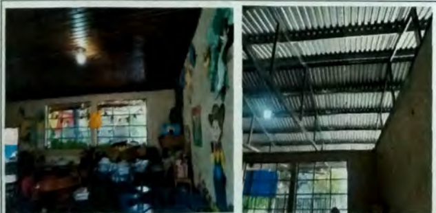
Foto 5: Vista de Modulo de aula, vista interior, retiro de cielo falso de madera en malas condiciones, cambio de estructura de madera por estructura de metal a base de tijeras y costaneras. cubierta de asbesto por lamina troquelada cal 26.
