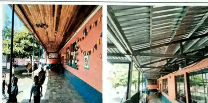
Foto 2: Vista de Modulo de aula, corredor, retiro de cielo falso de madera en malas condiciones, cambio de estructura de madera por estructura de metal a base de tijeras y costaneras. Cambio de cubierta de asbesto por lamina troquelada cal 26.
