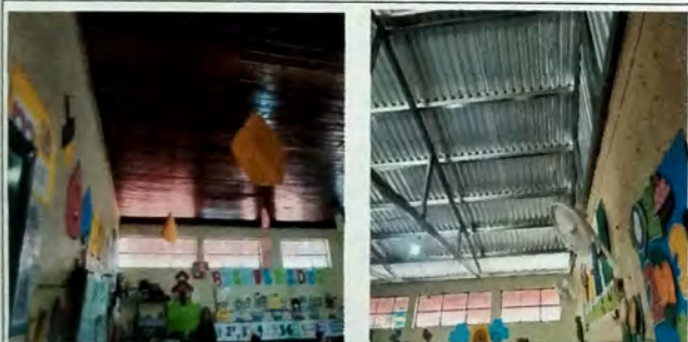
Foto 3: Vista de Modulo de aula, vista interior , retiro de cielo falso de madera en malas condiciones, cambio de estructura de madera por estructura de metal a base de tijeras y costaneras. Cambio de cubierta de asbesto por lamina troquelada cal 26.
