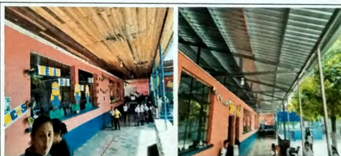
Foto 4: Vista de Modulo de aula, corredor, retiro de cielo falso de madera en malas condiciones, cambio de estructura de madera por estructura de metal a base de tijeras y costaneras. Cambio de cubierta de asbesto por lamina troquelada cal 26.
