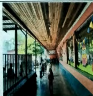
Foto 12: Vista de Modulo de aula, vista corredor, retiro de cielo falso de madera en malas condiciones, cambio de estructura de madera por estructura de metal a base de tijeras y costaneras. Cubierta de asbesto por lamina troquelada cal 26.
